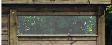
Wandelement mit Oberlicht. Vorteil: die Wandfläche im Inneren kann genutzt werden
