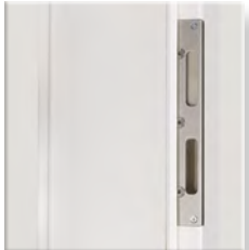
verstärktes Schließblech mit Stahlhalteplatte Nr. 35 Ansicht Futterbrett
